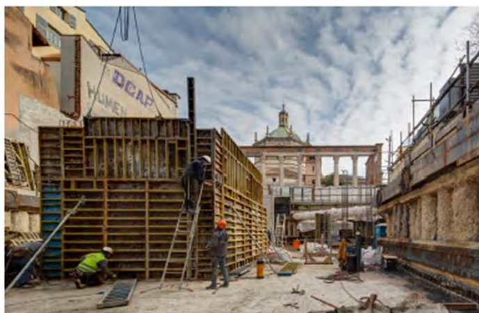
La realizzazione delle casseforme per il getto del vano marciafuori, marzo 2023 (foto di Piero Ottaviano)
