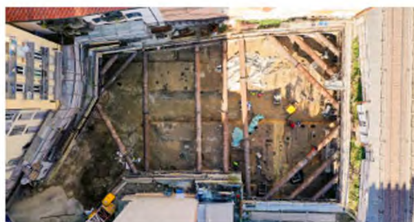
Vista dall'alto dell'area di cantiere, febbraio 2022 (foto di Piero Ottaviano) Il primo livello di pontoni posati e sullo sfondo la Basilica di San Lorenzo, febbraio 2022 (foto di Piero Ottaviano)
