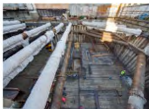
I lavori di scavo a quota -4,50 al doppio livello di pontoni, dicembre 2022 (foto di Piero Ottaviano) L'armatura della soletta in cemento armato e il doppio livello di pontoni di contenimento (foto di Piero Ottaviano)
