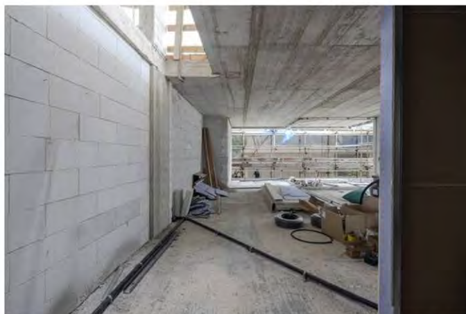
Murature esterne monostrato con il blocco Ytong Climagold da 48 cm in calcestruzzo aerato autoclavato (CAA). (Xella)
