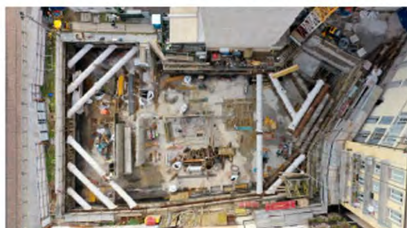
La realizzazione della platea di fondazione, marzo 2023 (foto di Piero Ottaviano)
