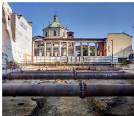
Vista dall'alto dell'area di cantiere, febbraio 2022 (foto di Piero Ottaviano) Il primo livello di pontoni posati e sullo sfondo la Basilica di San Lorenzo, febbraio 2022 (foto di Piero Ottaviano)
